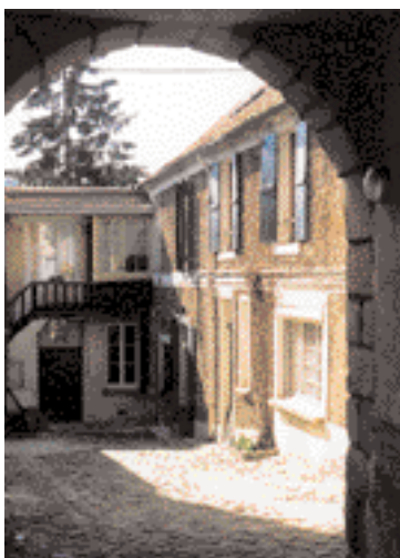
▲ Les cours sont pavées avec le grès* exploité dans les carrières locales.
